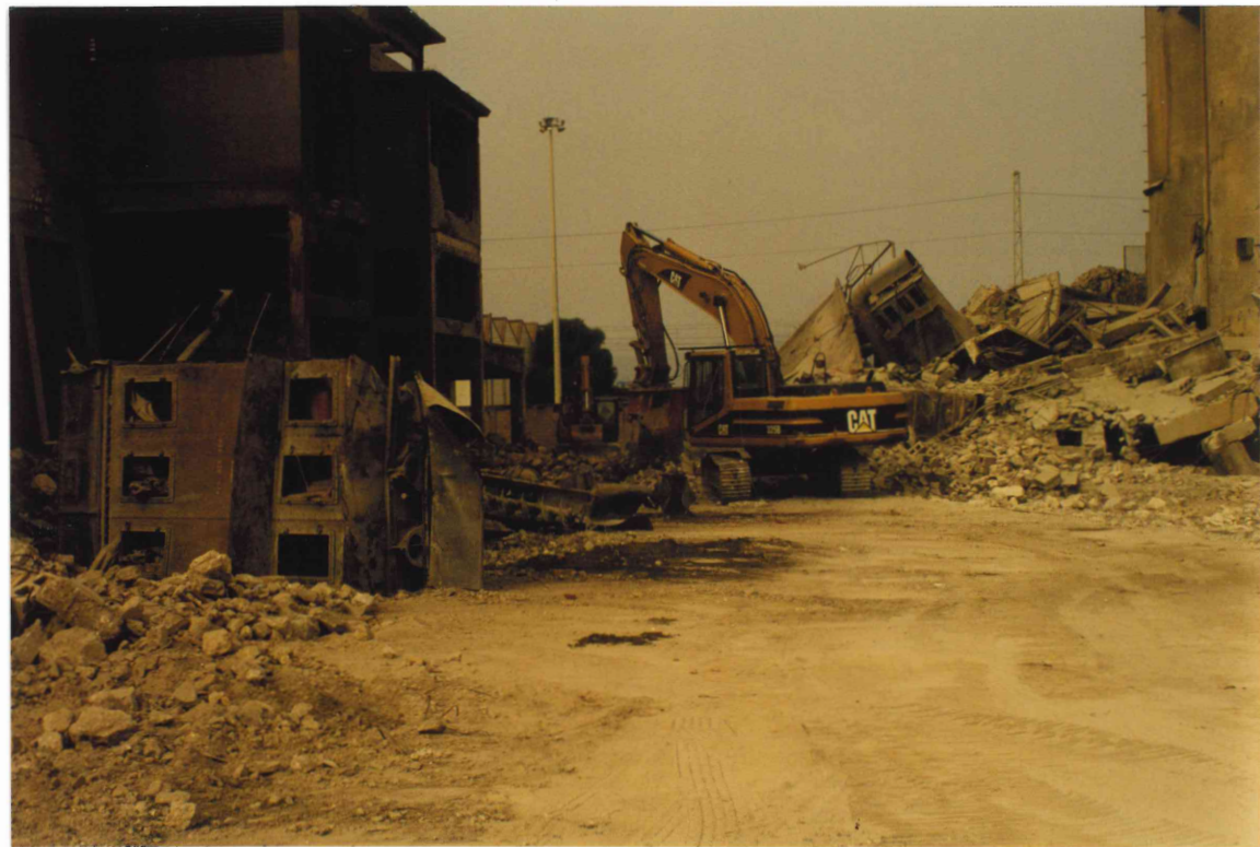
ESECUZIONE DELLA DEMOLIZIONE VECCHIA CEMENTERIA A SANTA GILLA , ANNO 2009
