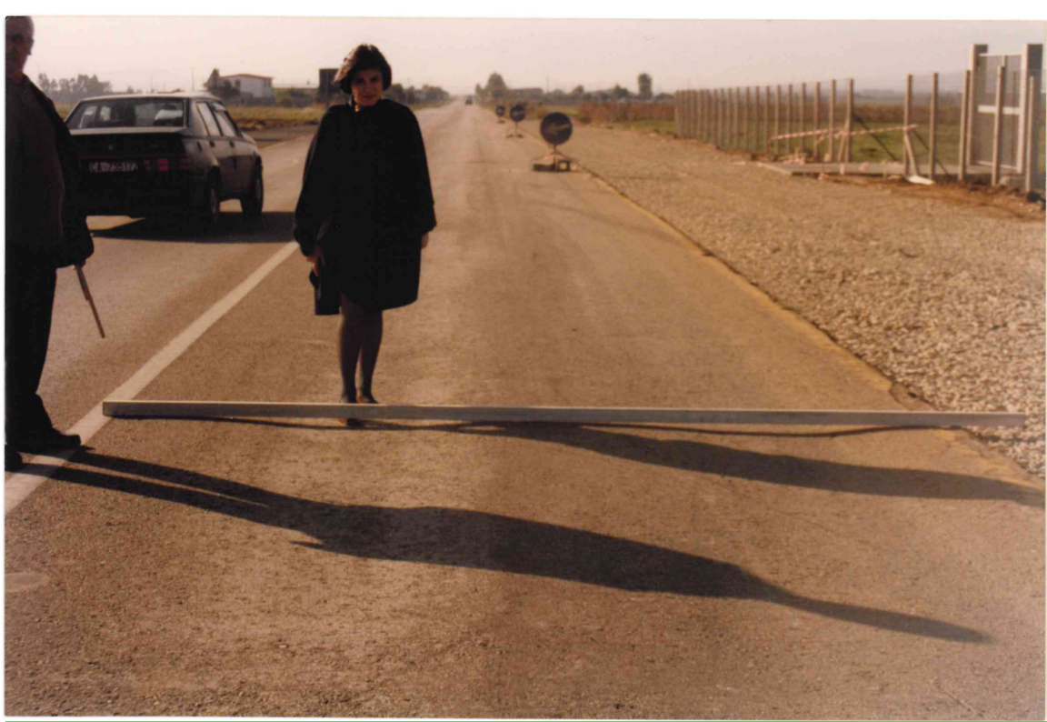
Prima di iniziare un nuovo lavoro di bitumatura, veniva effettuata una verifica diretta da parte mia
