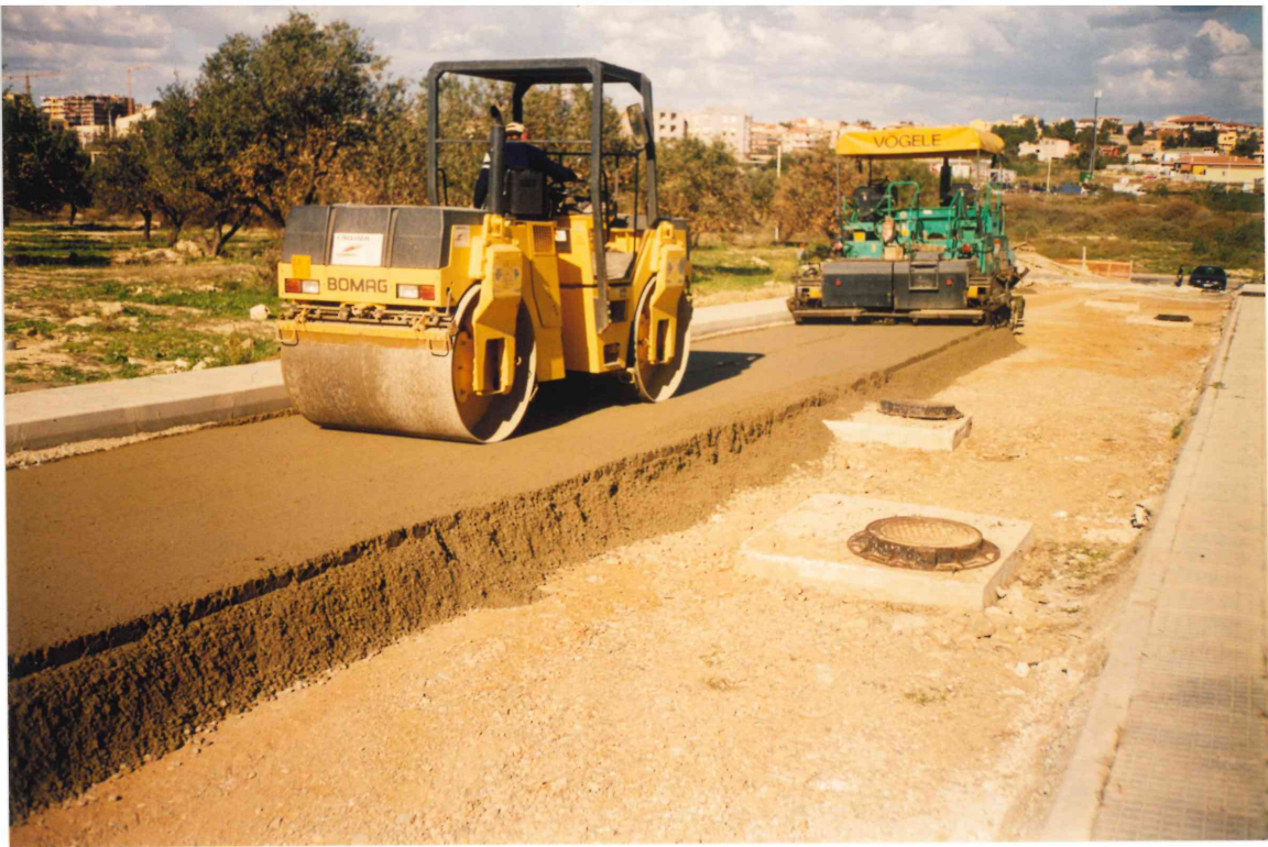
ESECUZIONE DI UNA SOTTOFONDAZIONE IN MISTO CEMENTATO
