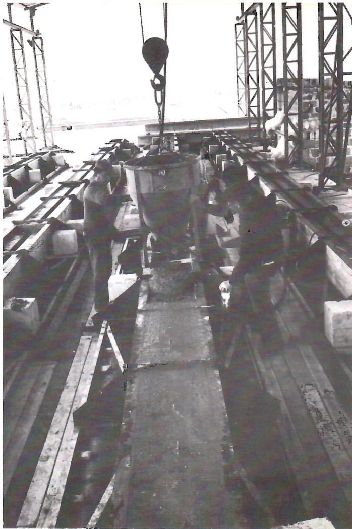
(A sinistra, in alto) Produzione travi a doppio T. Getto di una trave a doppio T entro le apposite casseforme metalliche
